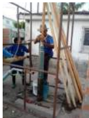
Manutenção de Bomba Hidráulica
