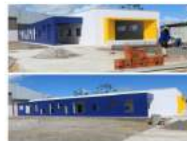
Construção do Prédio dos Contadores de História
