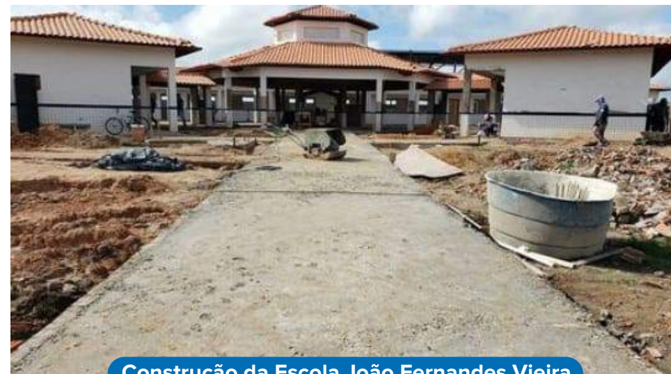
Construção da Escola João Fernandes Vieira
