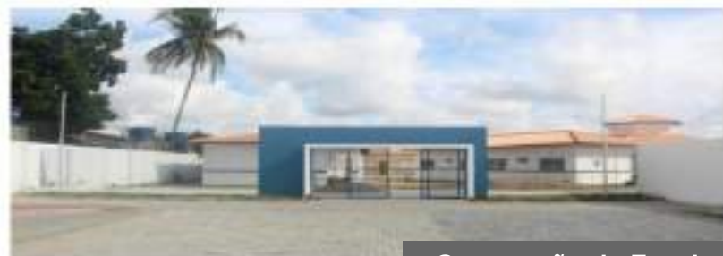
Construção da Escola Pedro de Oliveira
