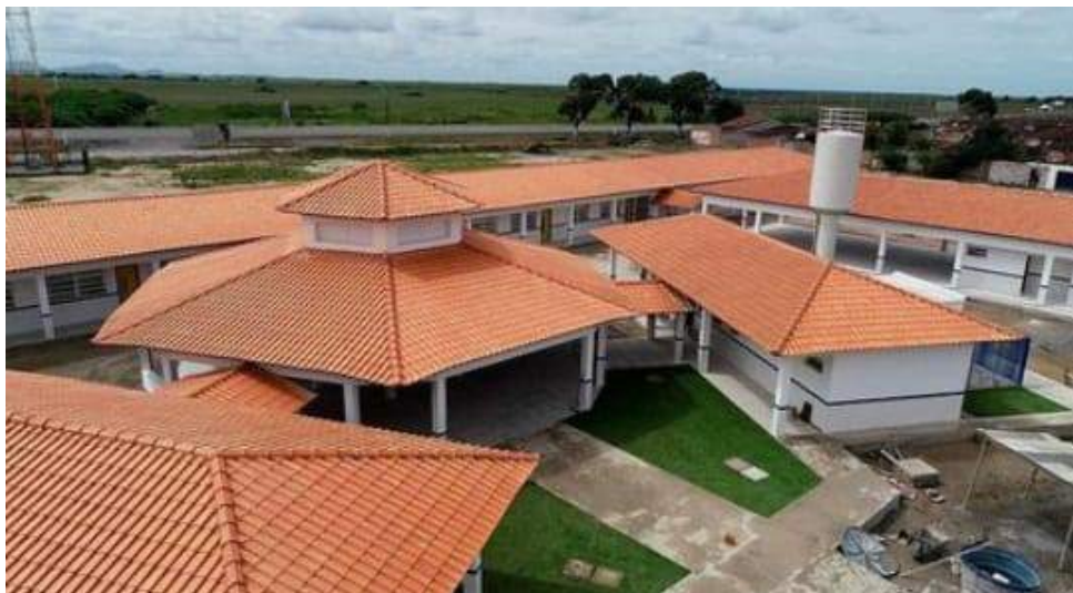
Construção da Escola João Rogério
