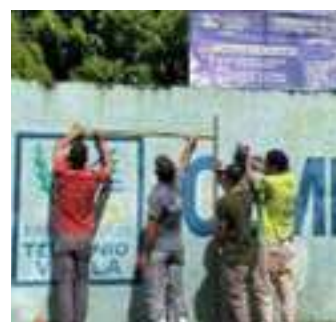
Obras de urbanização e fachada do Menino Jesus de Praga
