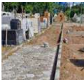
Calçamento das ruas do setor O2 do Memorial Parque das Mangueiras
