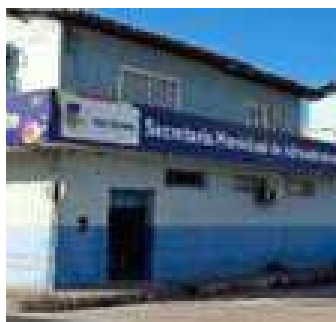
Revisão átrimonial na Sec. Infraestrutura
