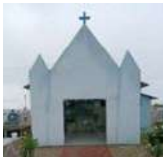
Capela do Cemitério do Gulandim
