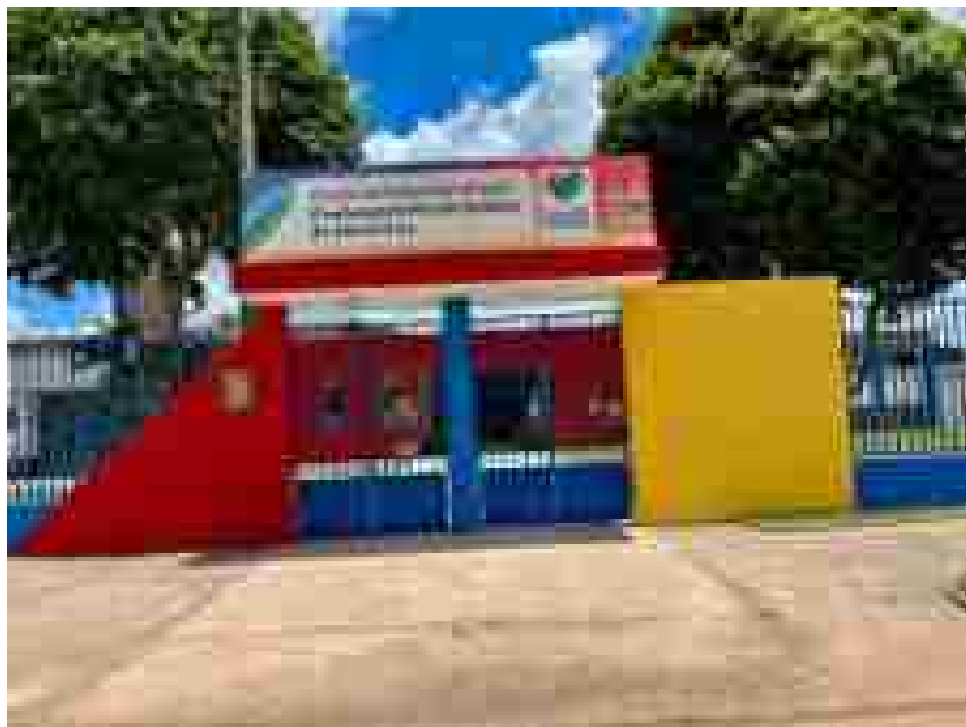
Serviços de manutenção e reparos nas unidades de ensino
