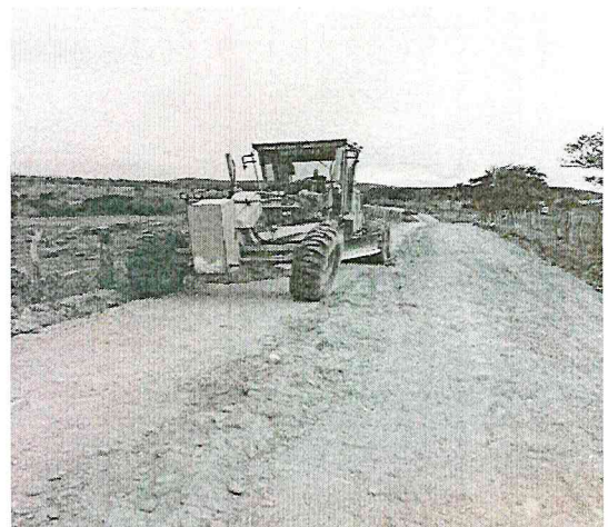
Recuperação de estradas
