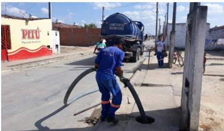
Foto 2: esgotamento de esgotos
