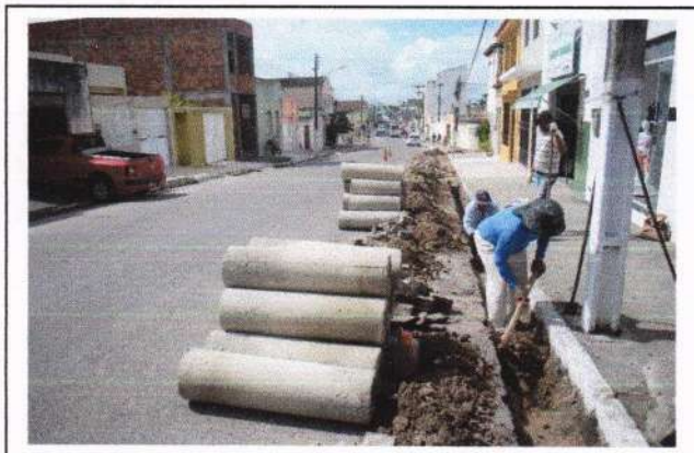
Localidade Rua Marechal Deodoro da Fonseca
