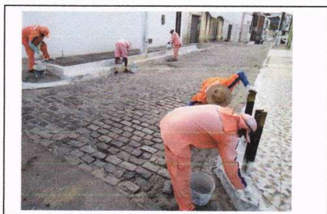
Pintura de meio fio;
