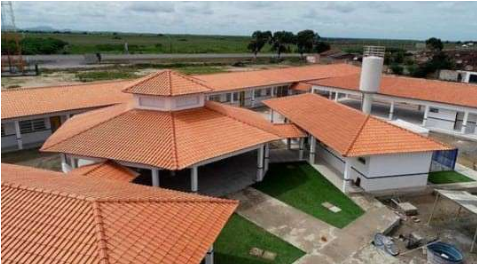
Construção da Escola João Rogério
