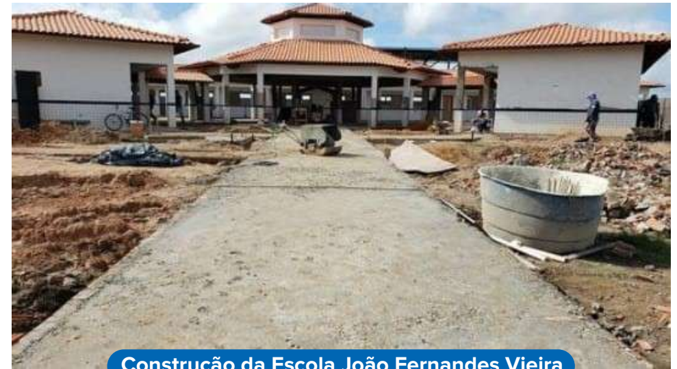
Construção da Escola João Fernandes Vieira
