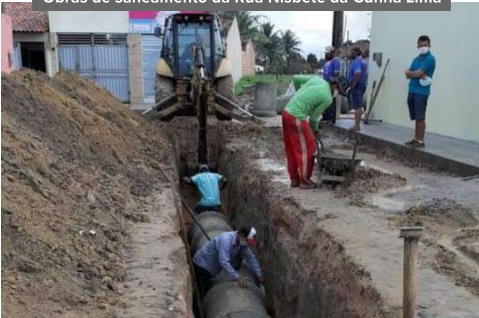
Obras de saneamento da Rua Nisbete da Cunha Lima
