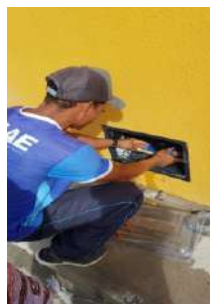
Instalação de hidrômetro
