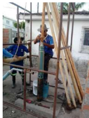
Manutenção de Bomba Hidráulica
