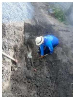
Conserto de vazamento
