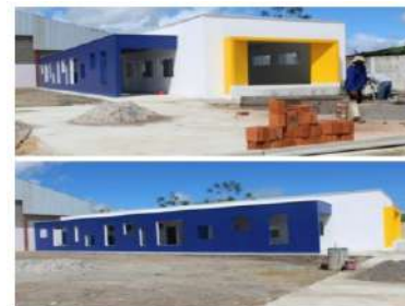
Construção do Prédio dos Contadores de História
