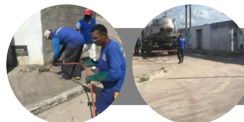
Manutenção da Rede de Esgoto
