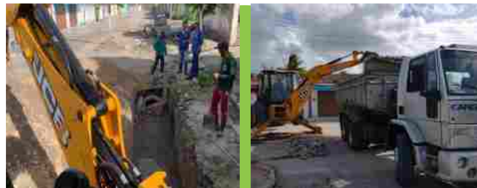
SERVIÇOS DE SANEAMENTO NAS RUAS DO MUNICÍPIO
