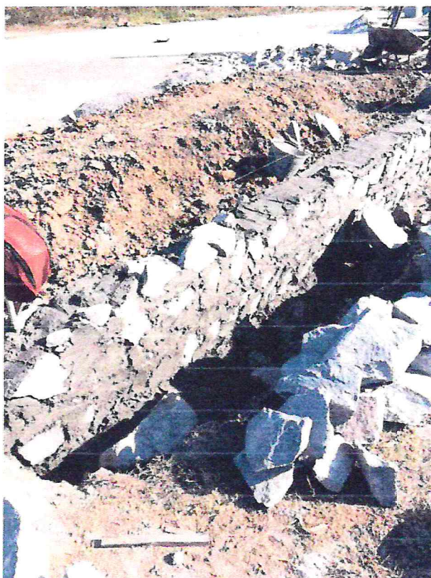
Escavação manual de vala e alvenaria de pedra
