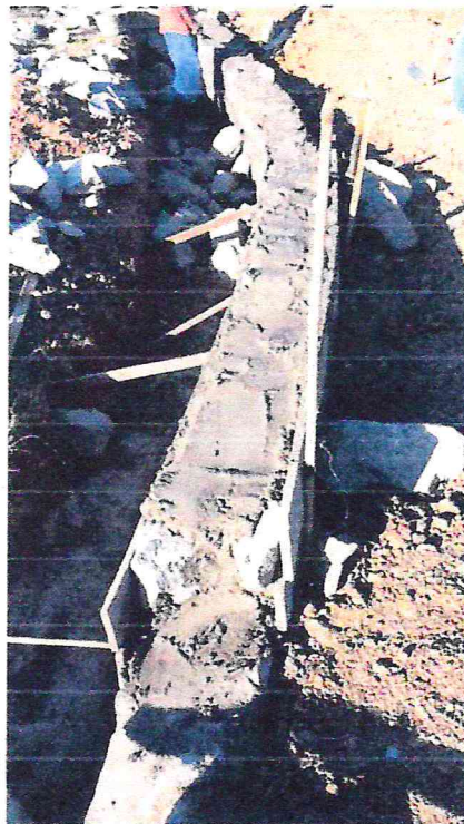
Alvenaria de pedra
