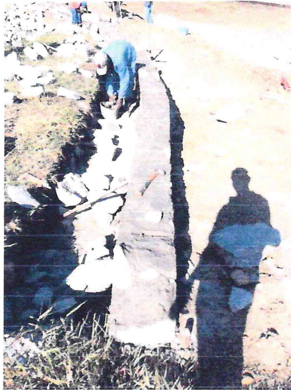
Alvenaria de pedra
