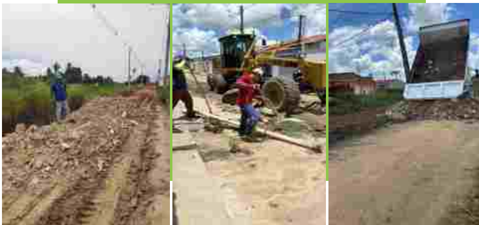
Terraplanagem em zona rural
