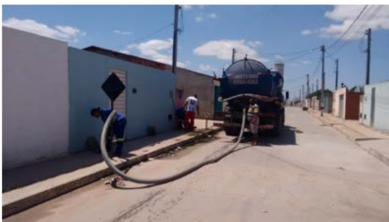
Esgotamento de fossas
