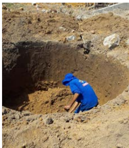
FOTO 4: INICIO DE ESCAVAÇÃO DE FOSSAS
