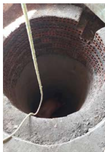
Foto 5: ESCAVAÇÃO DE FOSSAS
