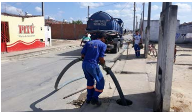
Foto 2: esgotamento de esgotos
