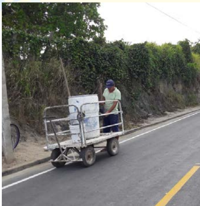
Foto 21: caiação em meio-fio
