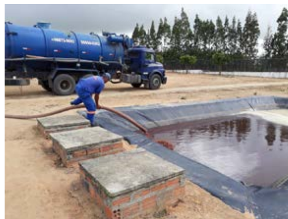
Foto 3: esgotamento das piscinas do matadouro municipal
