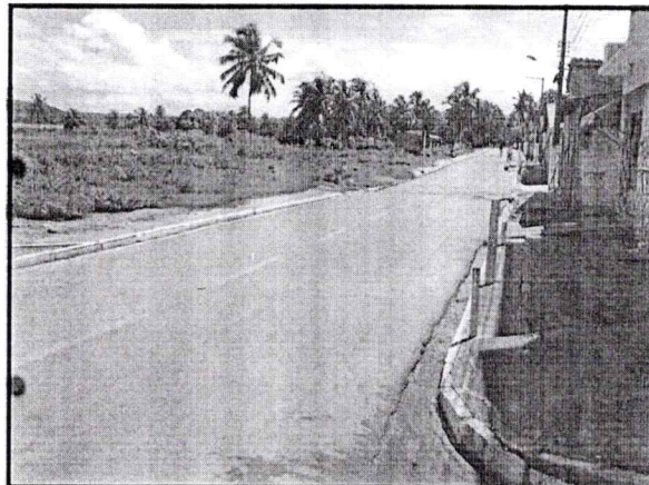
Figura 14: Pavimentação e Calçadas – Rua em Projeto 1 (31/05/2021)
