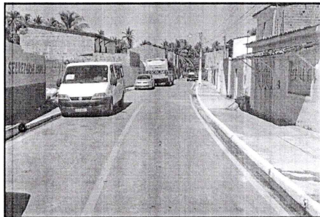
Figura 08: Pavimentação, Calçadas e Placas - Rua da Igreja (31/05/2021)
