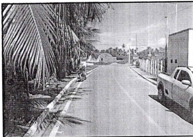
Figura 12: Pavimentação, Calçadas e Placas - Rua da Igreja (31/05/2021).
