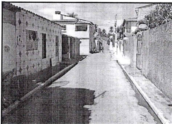
Figura 05: Pavimentação e Calçadas - Beco do Fernando (31/05/2021)
