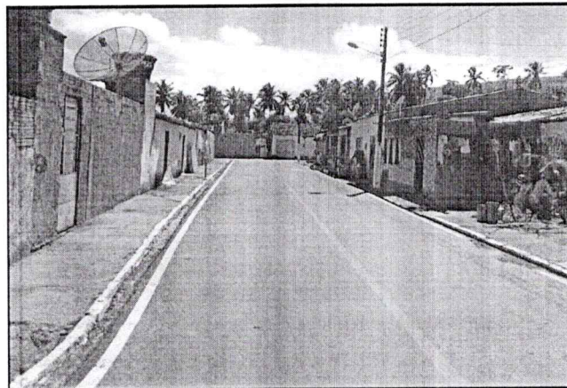
Figura 24: Pavimentação e Calçada – Rua em Projeto 4 (31/05/2021)
