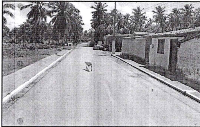
Figura 16: Pavimentação e Calçadas – Rua em Projeto 1 (31/05/2021)
