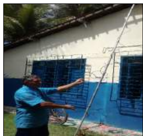
Figura: Instalação de equipamentos
