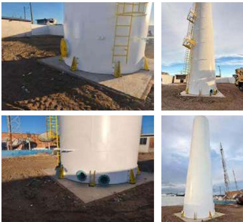
AMPLIAÇÃO E MELHORIAS NO SISTEMA DE ABASTECIMENTO DE ÁGUA DO MUNICÍPIO DE TEOTÔNIO VILELA/AL- CAPTAÇÃO ROCHEIRA
