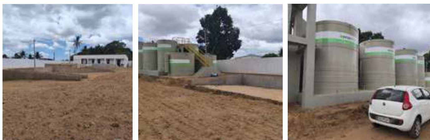
IMPLANTAÇÃO DE ADUTORA E ESTAÇÃO DE TRATAMENTO PARA REFORÇO DO SISTEMA DE ABASTECIMENTO DE ÁGUA – CAPITAÇÃO BAIRRO GERAIS VALOR: 20.000.000,00 – CONVENIO EM 2022.
