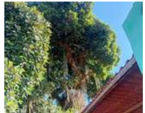
Figura 9: Galhos próximos a casa
